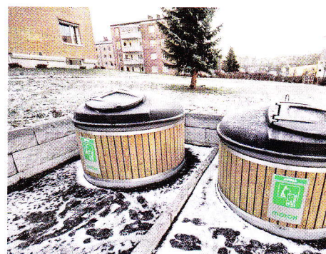
FINERE: Borettslagets nye avfallsbrønner.
